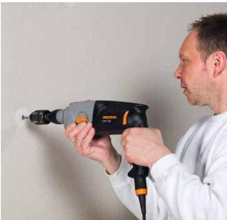
**7.** WDVS-Dübel in den Untergrund verschrauben.
