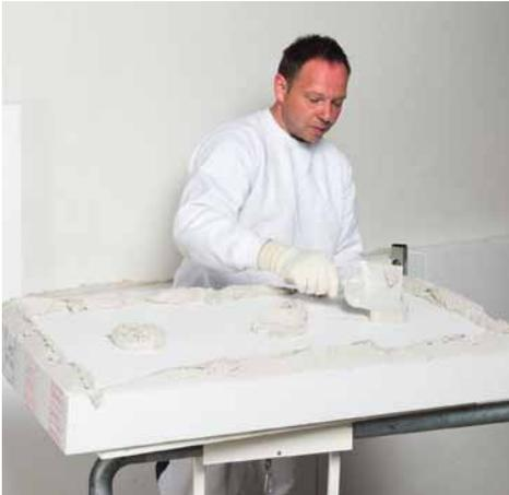
**1.** Klebeauftrag auf die Dämmplatte.
