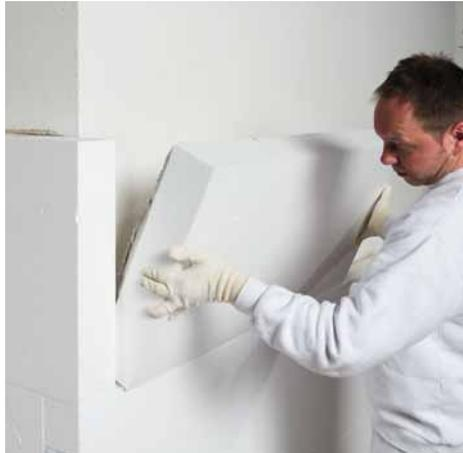
**2.** Dämmplatte passgenau auf dem Untergrund verkleben.
